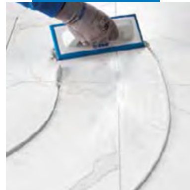
用橡胶抹子匀开大理石质的玻化砖上的填缝剂
