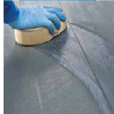
硬多孔海绵清洁和清洗砖缝
