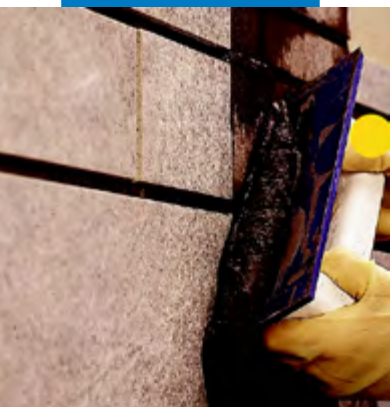
用橡胶刮板在墙上涂开马贝彩色防霉填缝剂2801
