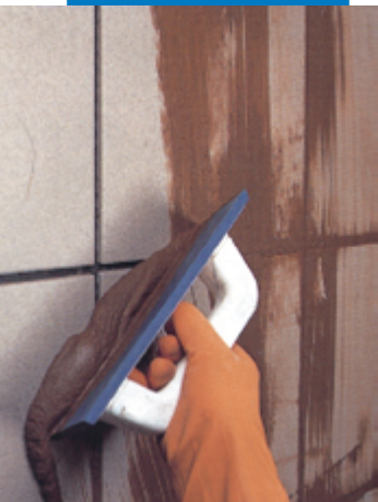
使用抹子在外墙填缝
