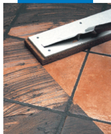
使用海绵扫帚在单 烧砖上清理
