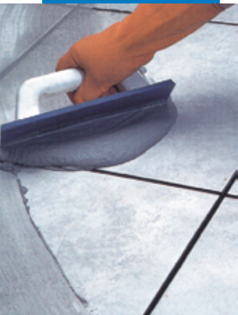
使用橡皮抹子在瓷砖地面上填缝
