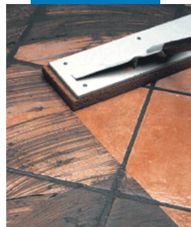
使用海绵扫帚在单烧砖上清理
