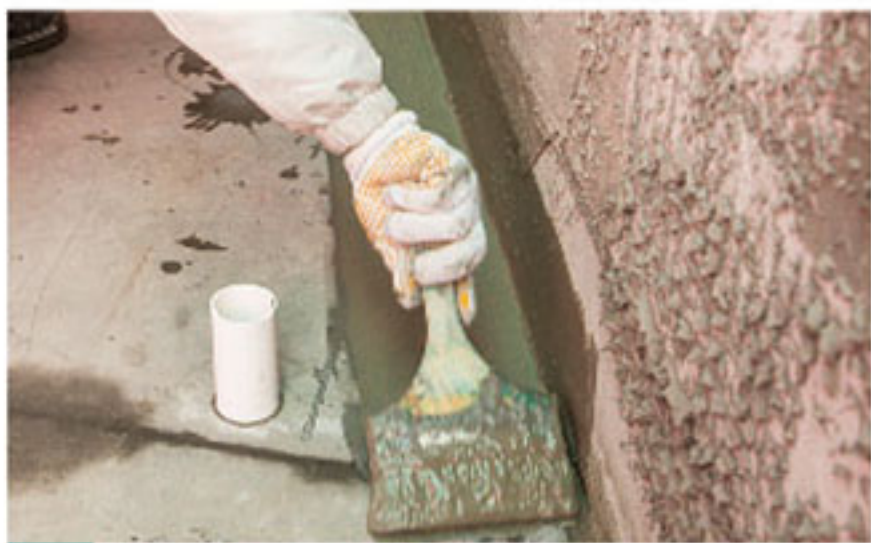
04 涂抹水不漏1号
