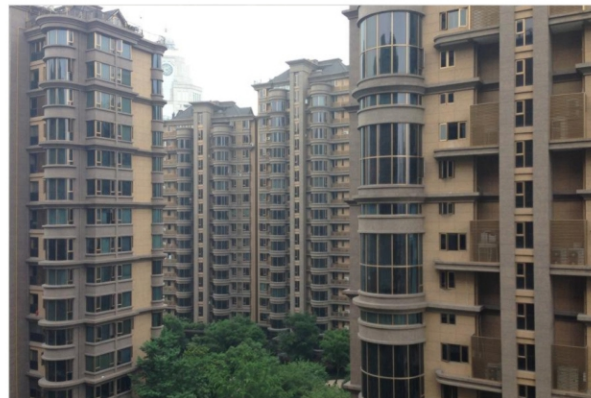
项目名称：中央公馆 工 艺：多彩涂料 面 积：70000m 2 〔浙江 温州〕
