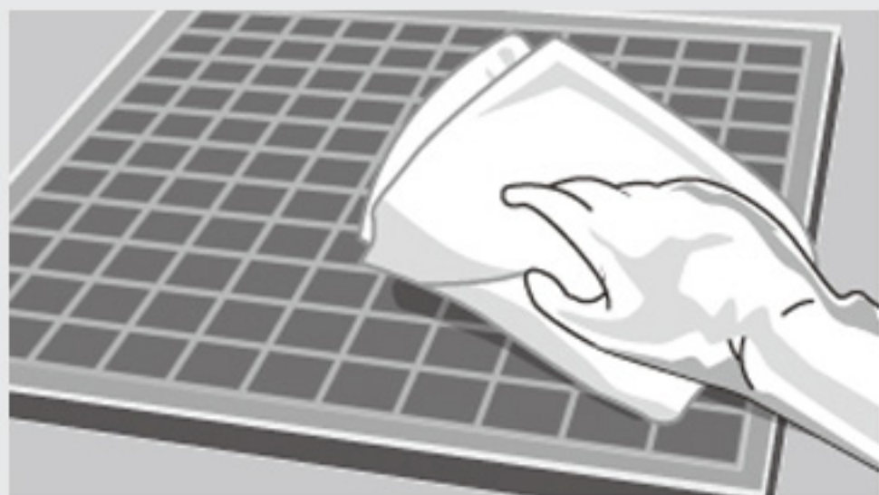
1. 清除瓷砖背面浮灰、油污、脱模剂等杂质
